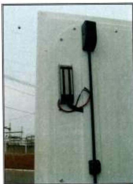
Figura 7 – Eletroímã do sistema de travamento da porta
