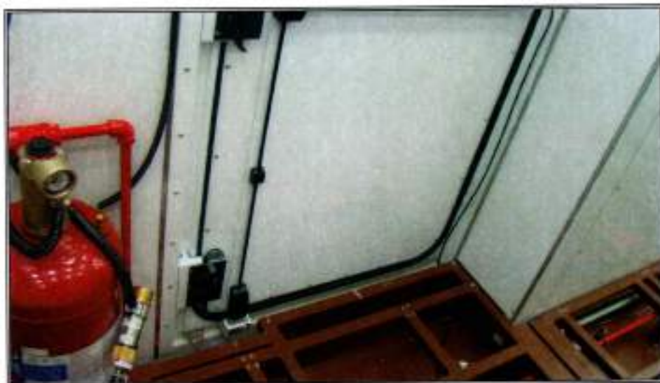
Figura 18 – Parte interna do container após ensaio de jato de água (inexistência de água em seu interior)
