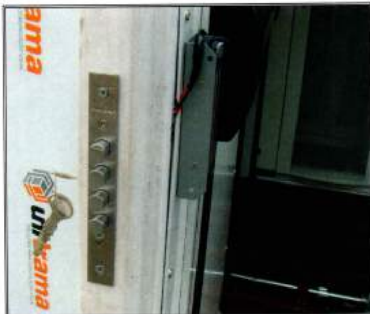
Figura 6 – Eletroímã do sistema de travamento da porta
