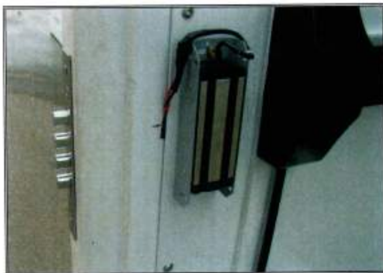
Figura 5 – Eletroímã do sistema de travamento da porta
